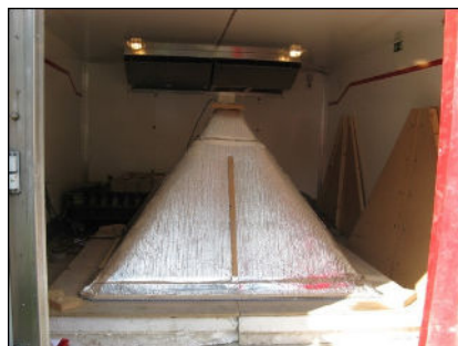
Figuur 2: Aluthermo Quattro® aangebracht over kepers
