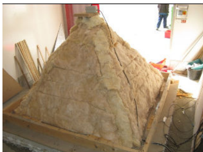
Figuur 1: Glaswol aangebracht over kepers
