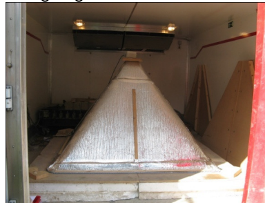
Abb. 2: Aluthermo Quattro® auf Dachbalken verlegt
