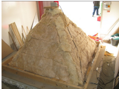
Abb. 1: Glaswolle auf Dachbalken verlegt
